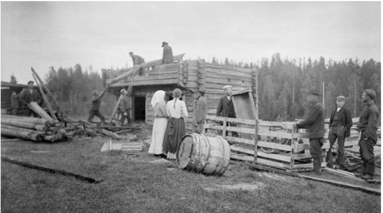
**Abb. 19** Kate Niemelä, Abbau des Pferdestalls für die Verlegung nach Seurasaari (beschnitten), Foto: Axel Olai Heikel (1909)
